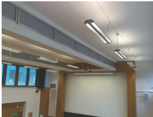
• obrázek 2: Nová osvětlovací soustava
