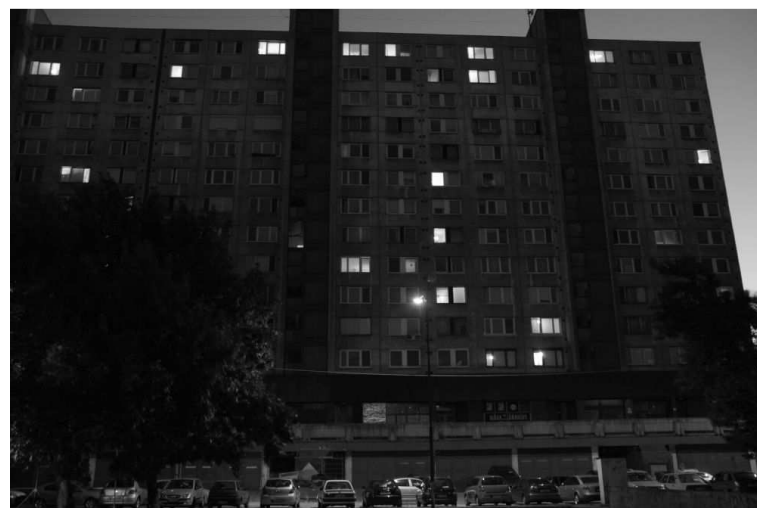
• obrázok 12 Bytový dom č. 2, pohľad zdola
